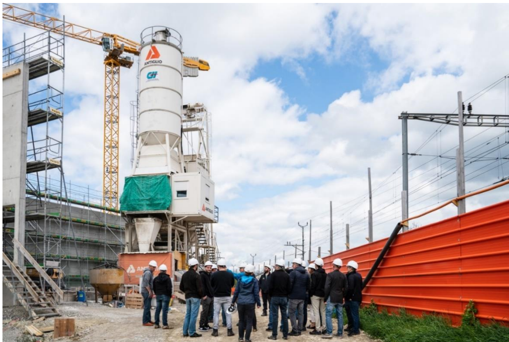
Baustellenbesichtigung auf dem Gelände der Terraviva ag/sa (© Vera Rüttimann)
