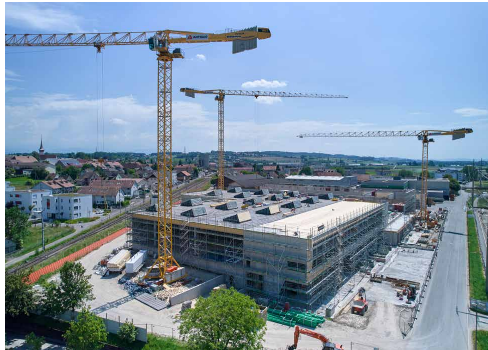
Die Realisierung des neuen Betriebsgebäudes der Terraviva ag läuft nach der Hälfte der Bauzeit wie geplant.
