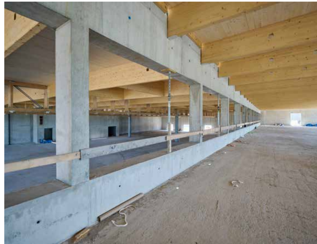
Die neue Produktionshalle: Hier werden künftig modernste Verarbeitungsmaschinen eingebaut.
